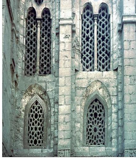
صوره ( 5 ) توضح ضريح السلطان قلاوون- القاهرة - حيث تظهر الاطباق النجمية الثمانية الاضلاع في النوافذ المفرغه
